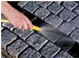
Steg 1. Rengör och blötlägg ytan ordentligt.
