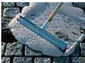
Steg 3. Fördela fogmassan. Med en gummiskrapa. Här kan vatten användas för att underlätta processen.
