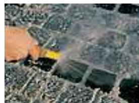
Steg 4. Vänta tills fogmassan är yttorr. Borsta bort överbliven fogmassan och spraya sedan ytan med vatten för att få bort resterna. Vänta 48 h innan ytan beträds.
