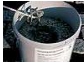
Steg 2. Förmixa Granuscan 855. Blanda sedan med bindmedlet till en jämn fogmassa, ca 3-5 min. Blanda ej i vatten!
